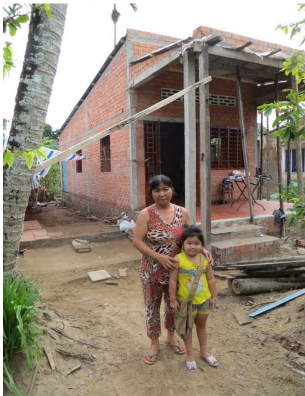
Maison de Mme Bùi Thị Kim Dung en construction (Vĩnh Long, 2014)
