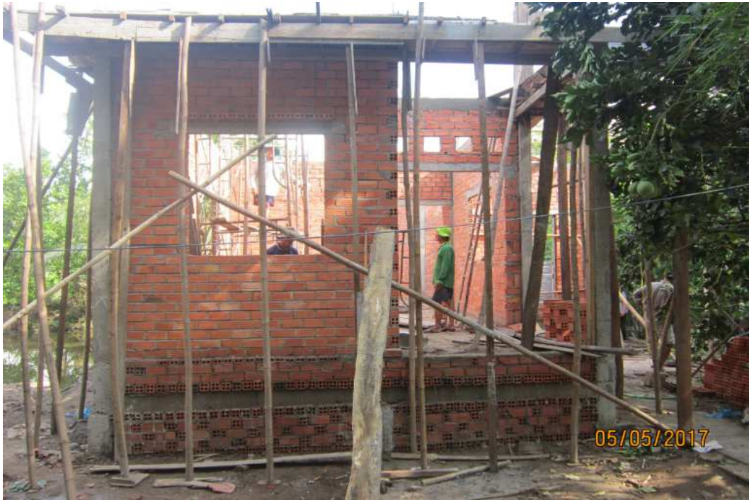
Nouvelle maison de M. et Mme Nguyễn Phúc Yên en construction (Vĩnh Long, 2017)
